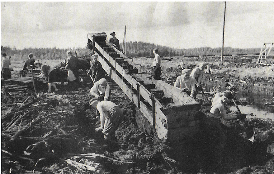
Aina 1950-luvulle saakka maamme yleisin turvekone oli ns. köysiratakone. Turve irrotettiin suosta lapiolla kuljettimelle, joka vei turpeet turvemyllyyn paloiksi muotoiltavaksi. Turvepalat vietiin kuivauskentälle köysirataa pitkin.
