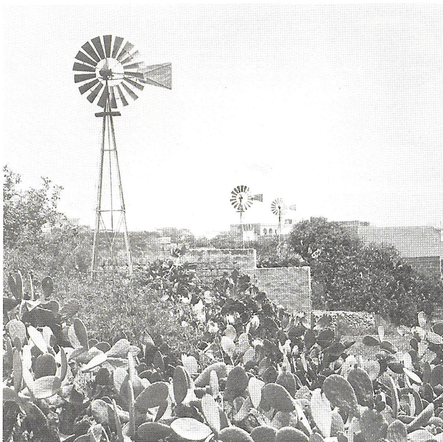
Tuulivoimaa käytetään pumppuamaan vettä Maltan pientiloille. Saastuttamattomien, uusiutuvien energialähteiden käyttö vähentäisi osaltaan ilman saasteita.
