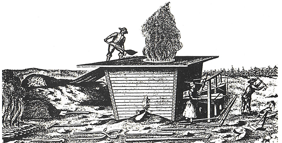
Keskiajalla rautaa valmistettiin palkeiden avulla toimivissa harkkoehyeteissä. Kun rautamalmista ja puuhiilestä koostuva panos oli sulanut, uunin toiminta oli keskeytettävä, jotta sen pohjalle jähmettynyt rautamöhkäle voitiin ottaa ulos.
