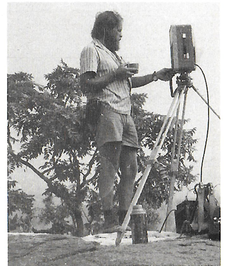
Runkomittaus Niger-joen lähetyksillä v. 1977 pataaltaan kartoitusta varten. Koje SIAL ja operaattori R. Tuominen.
