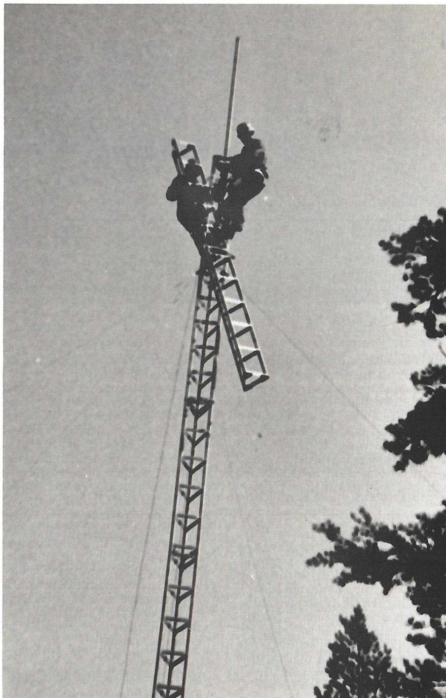
Suunta-antennia asennetaan taisteluharjoituksessa.
