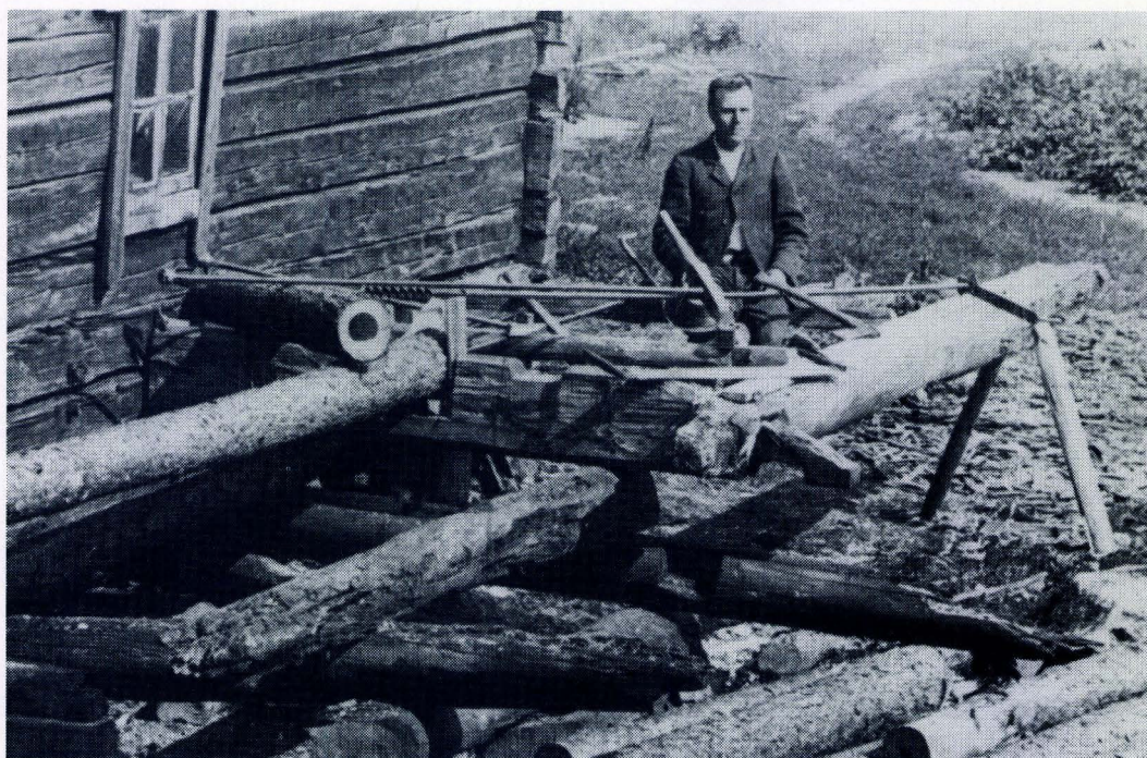
Puuputken kairausta vuonna 1913. Kuva: Vanhan Äänekosken kotiseutuyhdistys.
