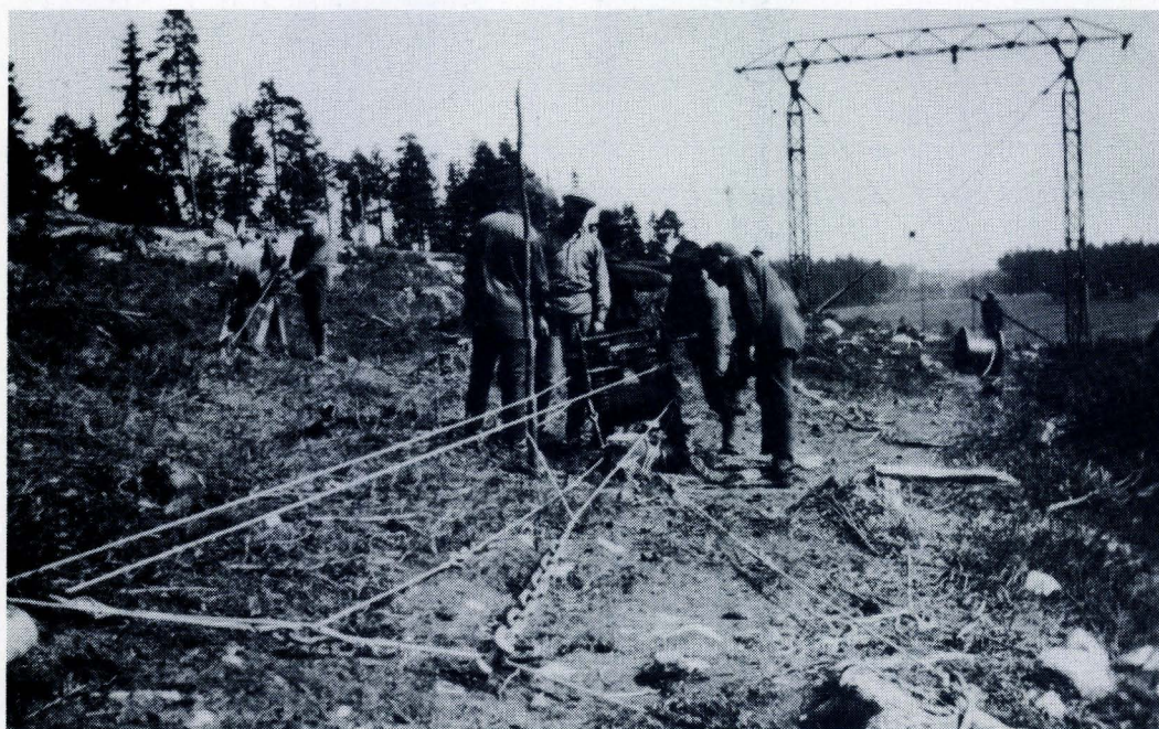
Imatra–Turku 110 kV johto rakenteilla. Kuva: Imatran Voima OY.
