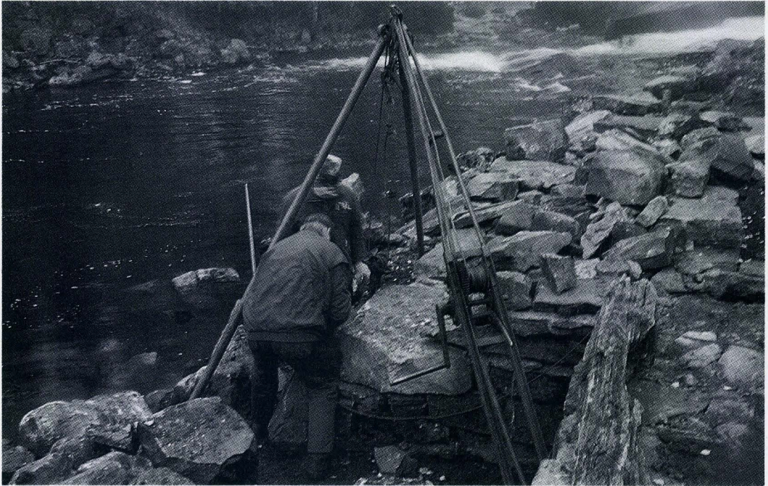
Uudemman masuunin vesivoimalaitteistojen tukimuurien kunnostamista. Tukimuureja peittäneet maat raivattiin kesällä 1996 ja luhistuneet osat ladottiin uudelleen. Kuva: MV/RHO, Karim Peltonen.
