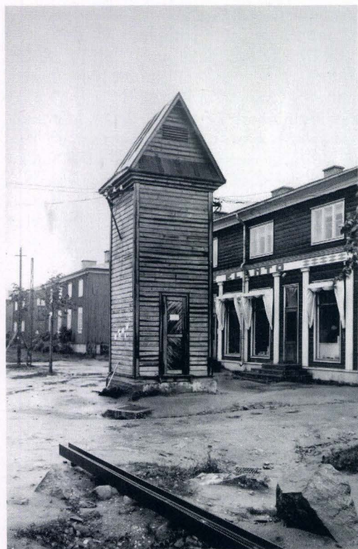
Puinen tornimuuntaja Käpylässä. Huomaa avojohdot.
