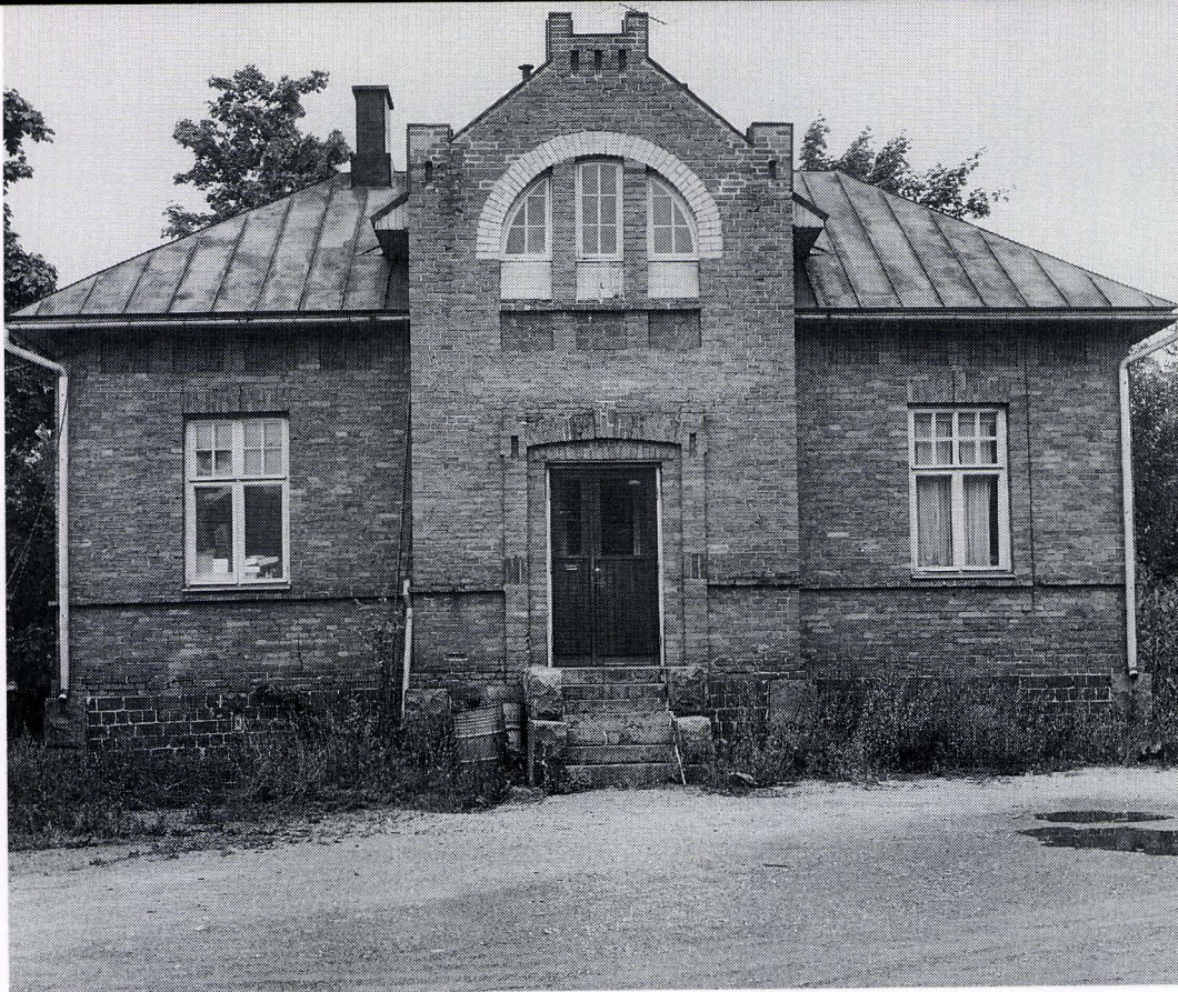
Vanha laboratoriorakennus 1909. MV Rak.hist.os. Erkki Härö.
