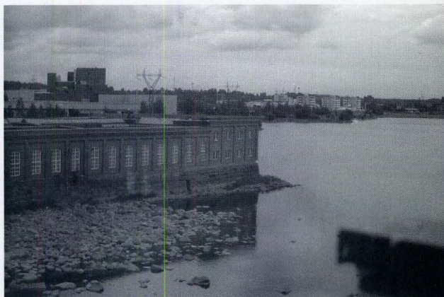
Inkeröisten kartonkitehdas 1800-luvun lopulta Ankkapurhan kosken äärellä. Tehtaan oikeanpuoleisin osa on arkkitehti Alvar Aallon vuonna 1946 suunnittelema laboratoriosiipi. Kuva: Henrik Wager.
