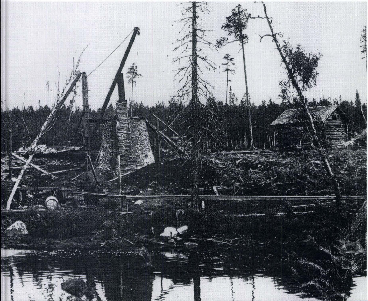
Löytöjoen tärpättitehdas noin 1930. Tärpätin vesihöyrytyslaitteisto sijaitsi vasemmalla olevassa vajassa.
