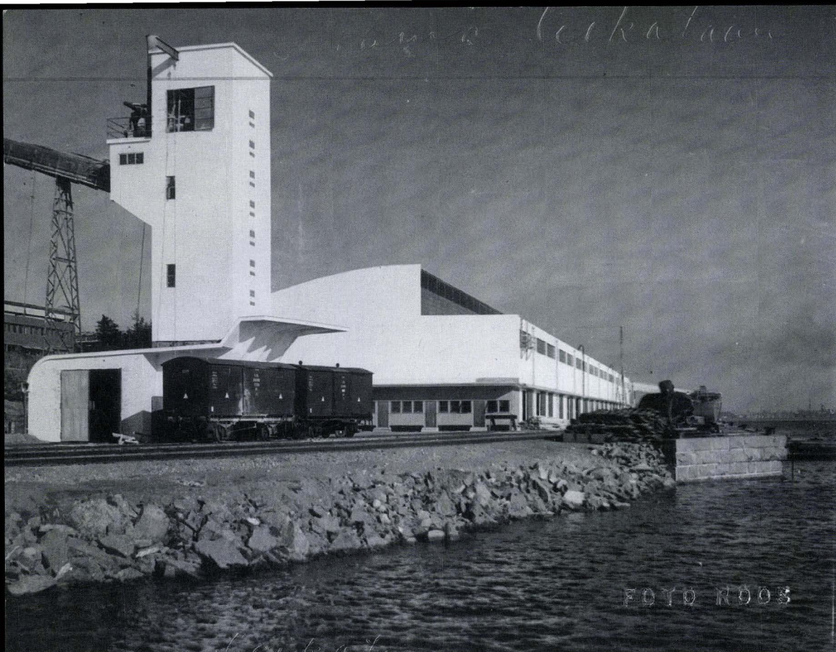
Sunilan satama-alueen kalkkitorni ja sulfaattivarasto. AAA. Kuva: Foto Roos.
