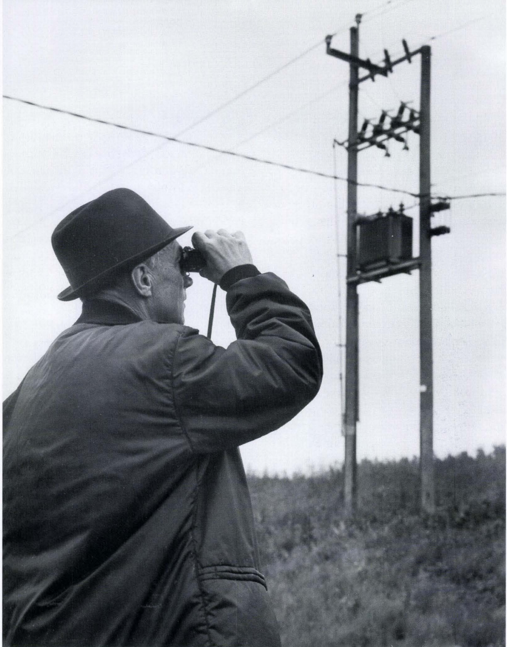
Sähkölaitosaston tarkastaja Olli Keckman tarkastaa pylväsmuuntamon rakennetta. Kuva: Sähkötarkastuslaitoksen arkisto.
