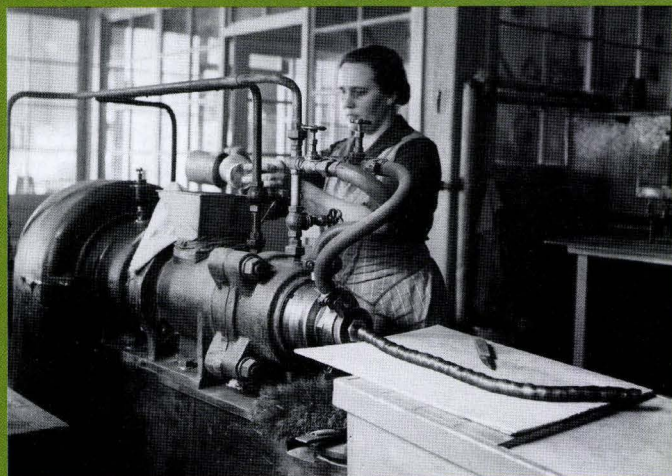
Kaseiinimuovin aineosat eli väriaineet, kaseiinijauho, vesi ja pehmitteet kaadettiin raaka-aineen sekoituskoneeseen (vasemmalla). Kaseiinimassasta valmistettiin tankopuristuskoneessa taikina- mainen tanko, joka leikattiin paloiksi (alla). Kuvat: V. O. Kanninen, 1930-luku, Tampereen museot.
