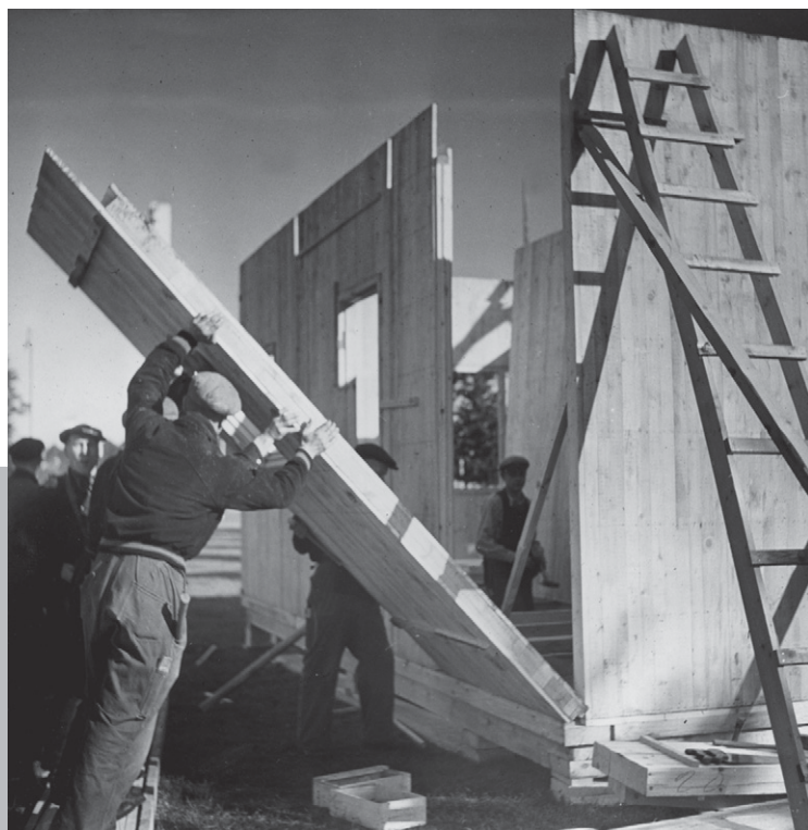
Elementtitalon kokoa- mista työnäytöksessä Messuhallin luona Helsingissä 1940. A. Ahl- ström Oy:n talotyyppi C3. Kuva: ELKA.
