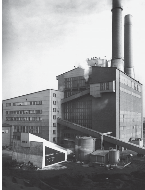
Moderni ja uusinta tekniikkaa edustava Hanasaari A -voimalaitos. Kuva: Helsingin Energian arkisto.
