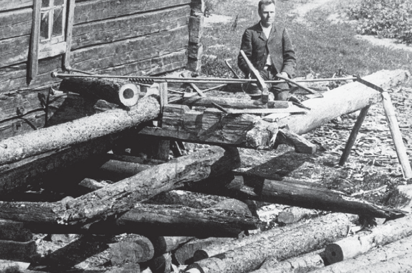
Puuputkien kairausta mäntytukeista Sumiaisissa 1913 Kuva: Vanhan Äänekosken kotiseutuyhdistys.
