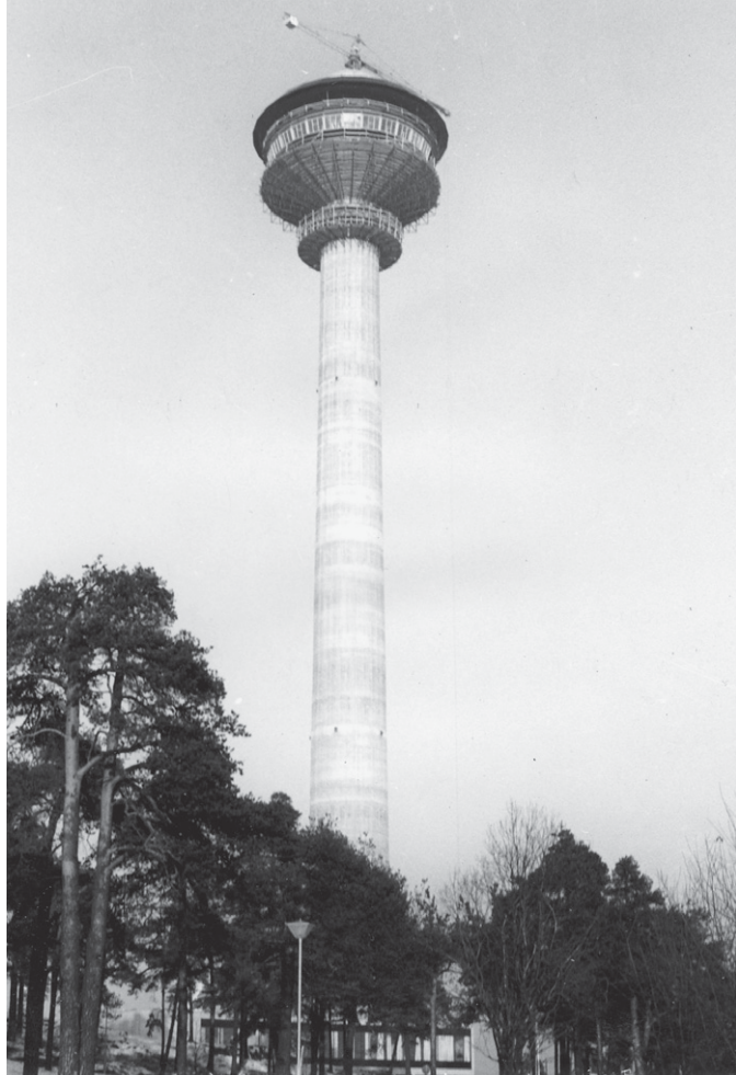
Torni lokakuussa 1970, jolloin hissiasennukset alkoivat. Kuvassa näkyvät ravintola-osan valumuotti ja nosturi katolla. Kuva: Ossi Grén.
