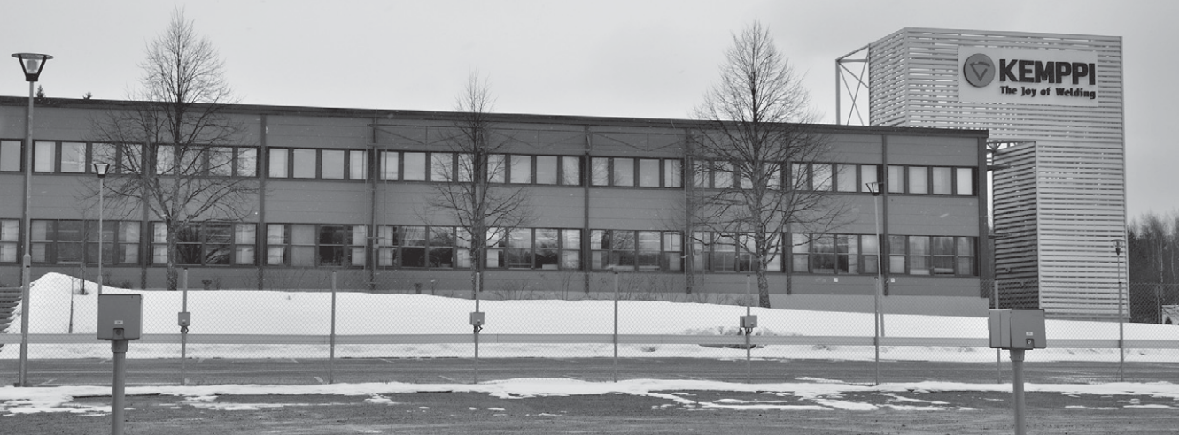
Kemppi Oy:n vuosikymmenten kuluessa laajentuneen tehdaslaitoksen julkisivu on yhtenäistetty ilmentämään 2000-luvun arkkitehtuuria. Kuva: Raimo Niskanen.
