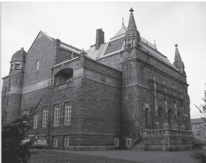
Turun taidemuseon (Gustaf Nyström 1901–1904) erikoisuutena on yläkerran näyttelytiloihin valaistuksen luovat kattoikkunat. Kuva: Jukka Lahdensivu.
