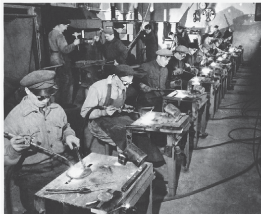
Rintamalta palaaval nuoret asemiehet oli sodan jälkeen nopeasti kiinnitettävä ammatillisen koulutuksen avulla yhteiskuntaan. AEL osallistui rintamamiesten pikakoulutukseen järjestämällä muun muassa sotakorvausteollisuuden kannalta tärkeitä hitsauskursseja. VALOK. FOTO ROOS, AEL.
