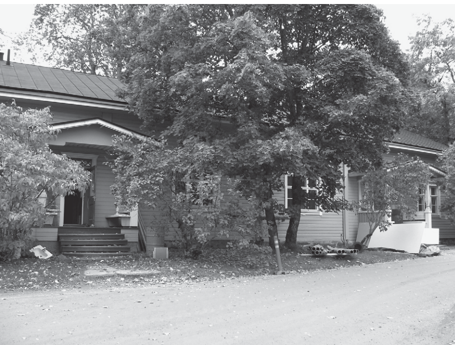
Entisen metsäkonttorin eli Sahalan saneerausvaihe syksyllä 2009. Julkisivultaan suojeltu rakennus koki sisältä miltei täydellisen muutoksen. Kuva: Maarit Grahn.
