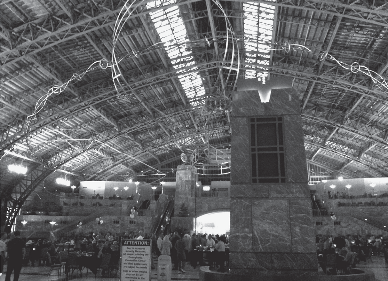
Entinen Reading Terminal -rautatieasema, nykyinen kongressikeskus. Maailman vanhin kattorakenne laatuun ( single-span arched-roof ) ja ainoa USA:ssa jäljellä oleva. Kuva: Markus Kari.
