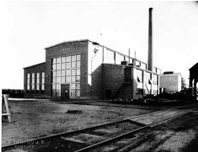
Takapuristinlaitoksen rakentaminen alkoi vuonna 1937.
