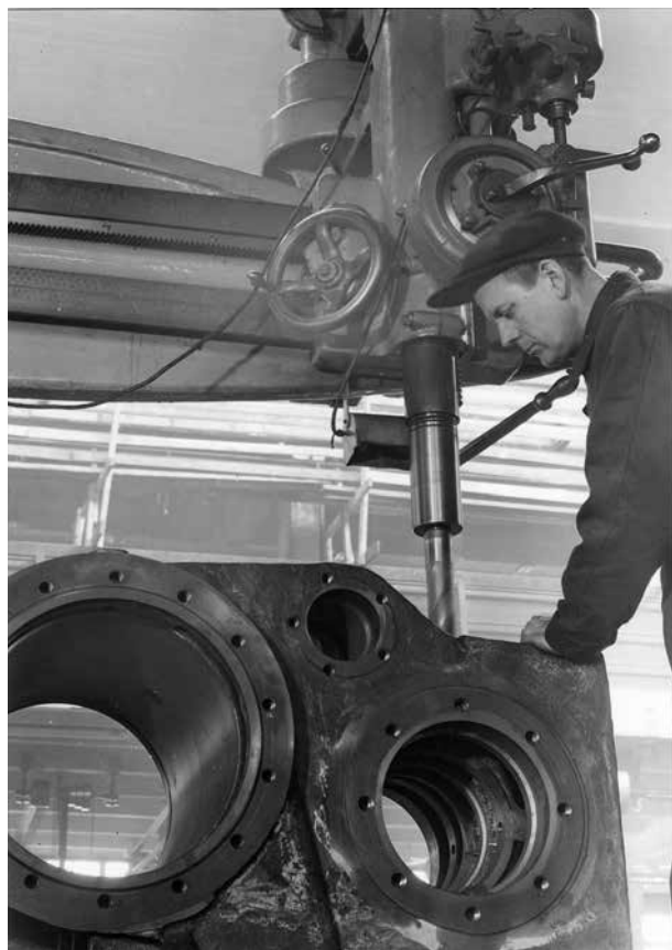
Sotakorvauslokomobiiliin sylinterin porausta Porin Konepajalla. Valokuva Satakunnan Museo.
