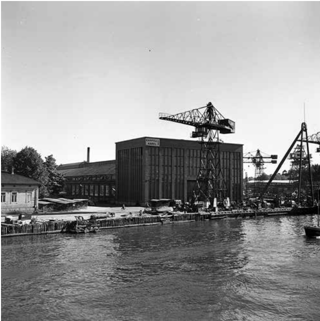
Konepajarakennus Aurajoen itärannalla valmistui vuonna 1939. Myöhemmin vuonna 1958 sitä laajennettiin paljon suuremmalla lisäosalla ja kuvassa vasemmalla näkyvä puutalo sai väistyä. Kuva: Wärtsilän Turun telakan kuva-arkisto.
