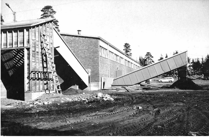
Kuva 2. Turun pikalahottamon eli Dano-biostabilisaattorilaitoksen mittasiilo ja rejektikuljetin. Kuva: Lounas-Suomen jätehuolto oy. Turun kaupunginarkisto, Kiinteistö- ja rakennustoimi, Katurakennusosasto, Valokuvat, Ja:2.
