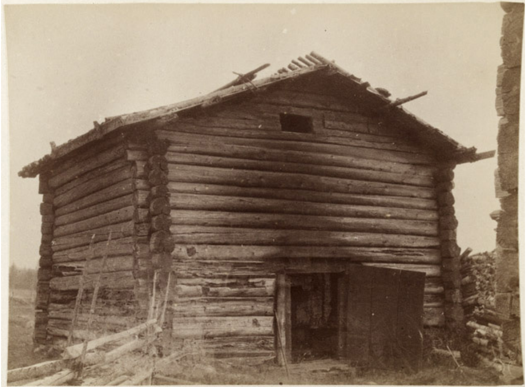
Kuva 1. Suomalaiset riihet eivät olleet teknisesti vaikeita rakentaa, mutta niiden käyttö vaati silti taitoa. Kuvassa (vuodelta 1894) on Sotkamon Riihilehdon vanha riihi, joka oli rakennettu seinässä olleen vuosiluvun mukaan 1746. Kuvaaja Yrjö Blomstedt. Kansatieteellinen kuvakokoelma, Museovirasto.
