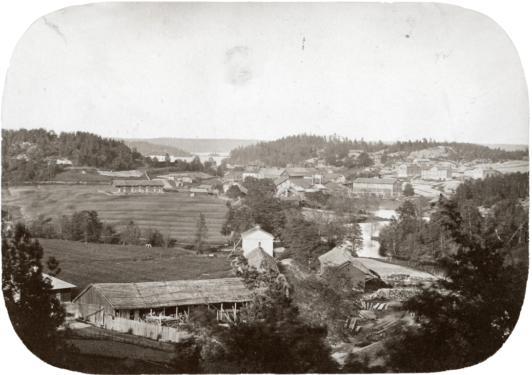
Kuva 2. Fiskarsin yläruukki vuonna 1865. Etualalla vaalea talo on Kardusen (1843). Sen takana Peltorivin asuintalojen kattoja. Kuvan keskellä valssilaitos (1859), konepaja (1837) ja sen konttori (vaalea rakennus; nykyisin Fiskarsin museo). Kuvan vasemmassa yläkulmassa Rosehill (1837) ja oikealla Kullan talot (1859). Kuvaaja C.J. Malmberg. Lähde: Fiskarsin museon kuvakokoelma.
