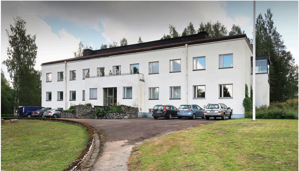
Kuva 9. Uno Ullbergin suunnittelemaa entistä Outokumpu Oy:n pääkonttoria lähdettiin pelastamaan rappeutumiselta vuonna 2017. Tuolloin perustettiin Okun Konttori Oy, joka hankki rakennuksen omistukseensa ja läksi kunnostamaan sitä. Kuva Pekka Piiparinen.
