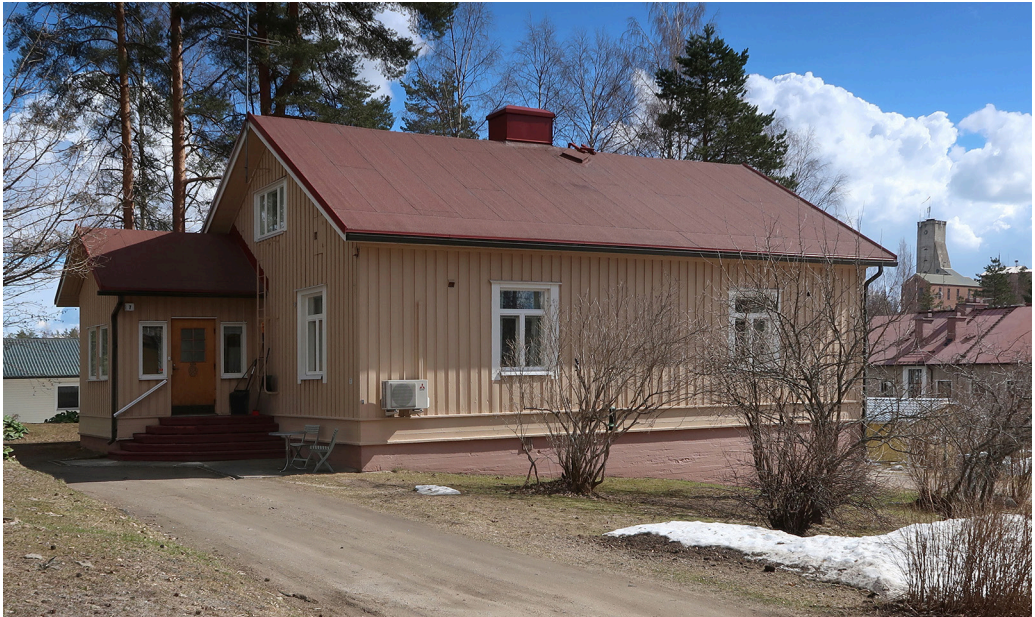
Kuva 4. Kyykerin asuinalueelle valmistui 1930-luvun jälkipuoliskolla 37 tyyppipiirustusten mukaan suunniteltua kahden perheen taloa. Tähän päivään taloista on säilynyt 24. Kuva Pekka Piiparinen.
