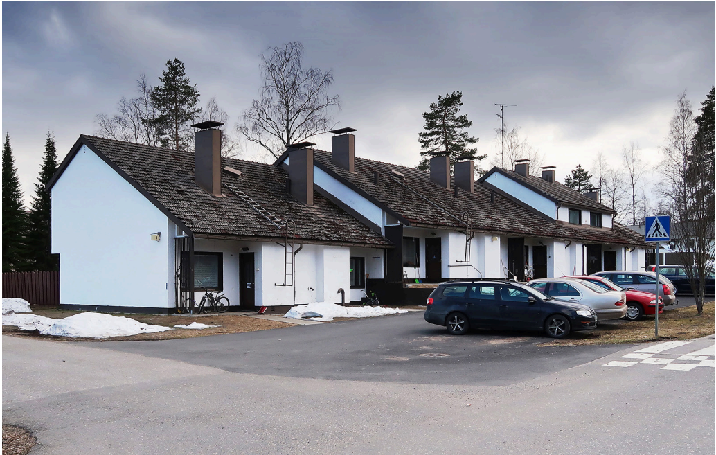
Kuva 2. Rivitalo osoitteessa Kyykerinkatu 3 on esimerkki 1950-luvulla virkailijakunnalle ja työnjohdolle suunnatusta modernista asuntotuotannosta. Kyykerin asuinalueelle vuonna 1957 valmistuneen rakennuksen suunnitteli Arkkitehtitoimisto Blomstedt & Lampén. Kuva Pekka Piiparinen.
