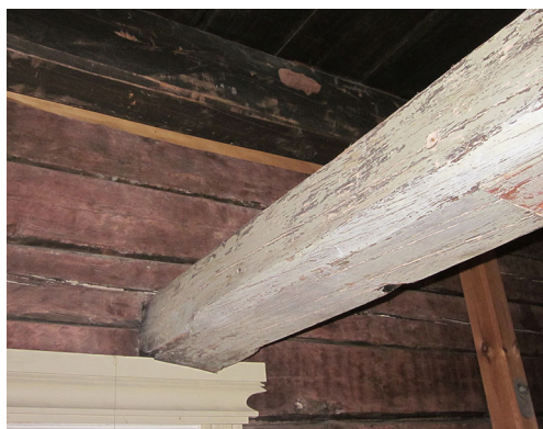
Kuva 7. Latva-Talvitien tuvan vasen takkihirsi kääntyneenä keskiföljäriä kohti. Kuva Matti Mäkelä. MMK.
