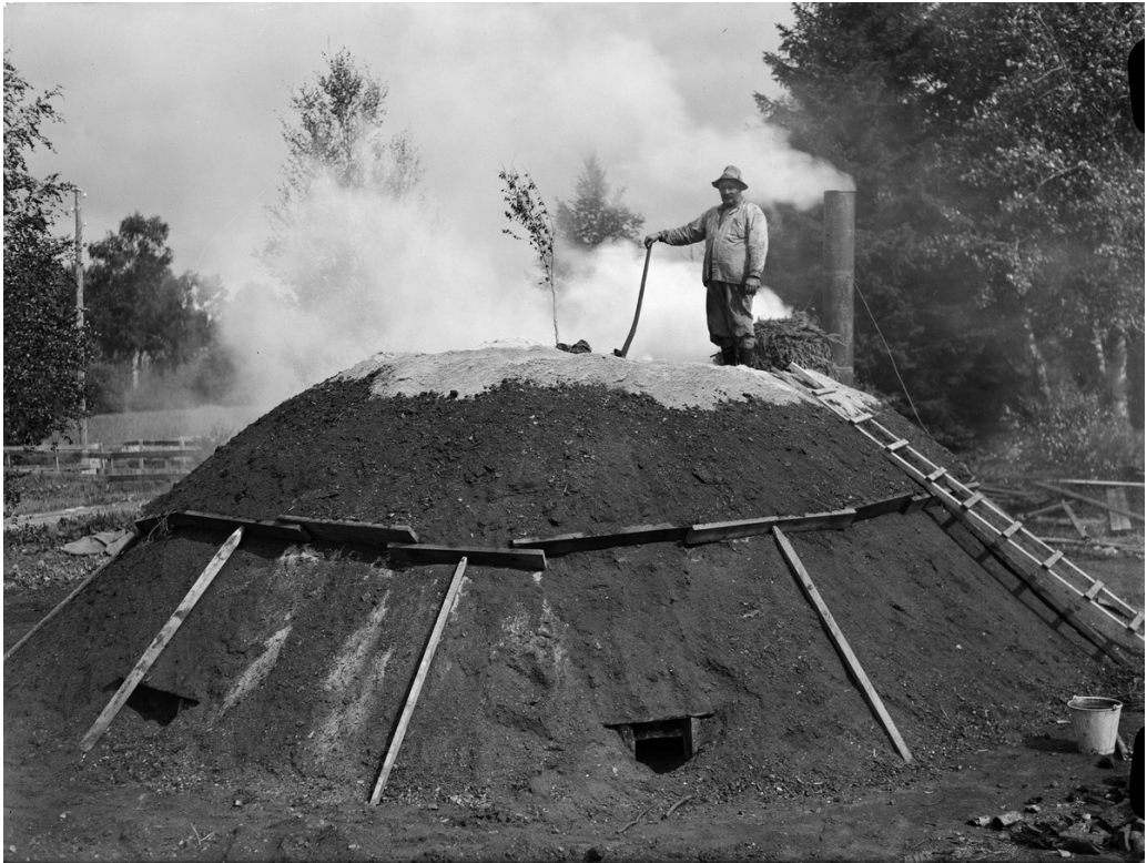
Kuva 3. Torvimiilu Ruotsissa vuonna 1940. Miilun juuressa erottuu kaksi ilmanvaihtoaukkoa eli jalkaluukua. Kuva: Sandberg, Paul / Upplandsmuseet (CC BY-NC-ND)
