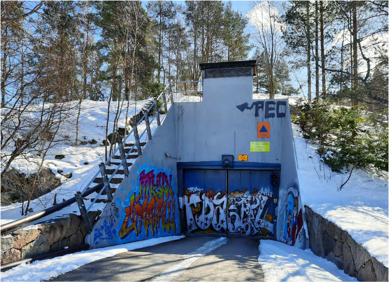
Yleisiä väestönsuojia on rakennettu alueille, joilla on paljon liikkuvaa väestöä.
