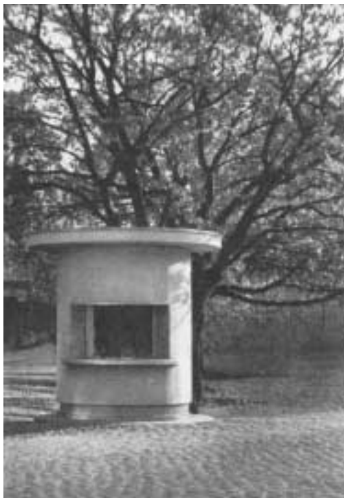
Kuva 3: Gunnar Taucherin suunnittelema betonirakenteinen pyöreä tyyppikioski Kasarmintorilla. Arkkitekten 1/1929 kansikuva.
