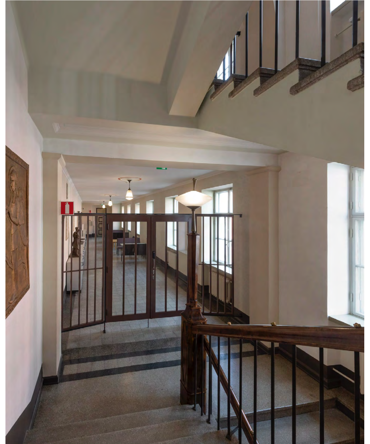
3. ja 4. kerroksen aulakäytäviin on rakennettu uudet väliseinäkkeet lisäämään toimistohuoneiden työskentelyrauhaa.
