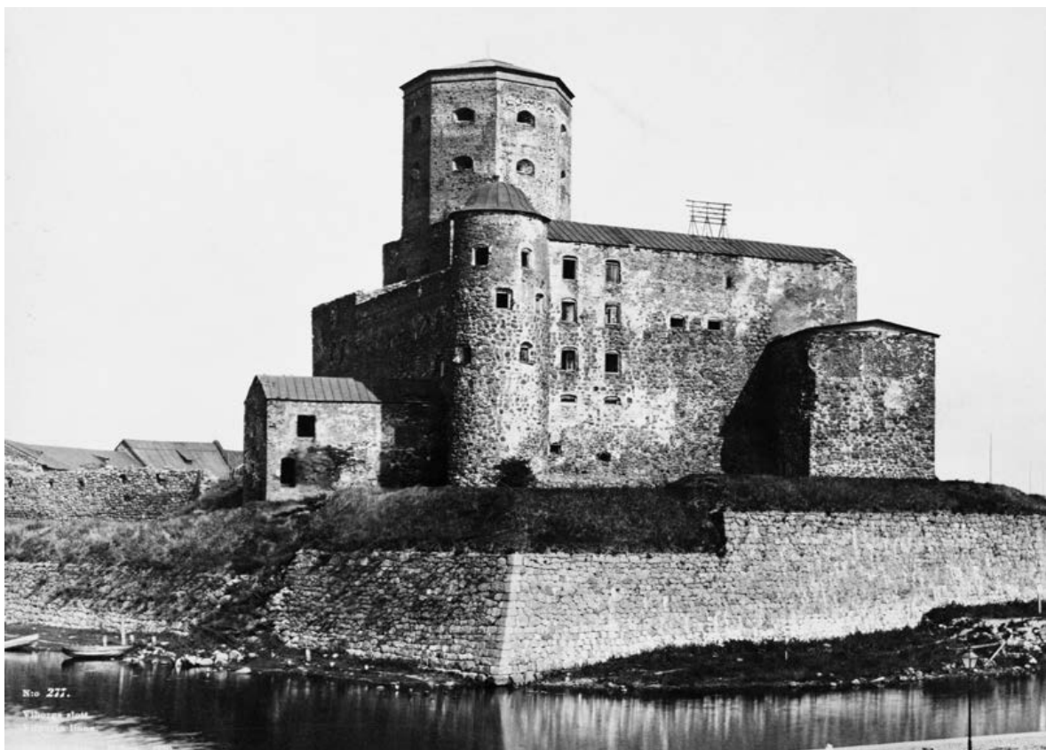
Viipurin linna oli ennen restaurointia erittäin huonokuntoinen. Sen saattaminen käyttökuntoon edellytti mittavia uudelleenrakennustoimia.
