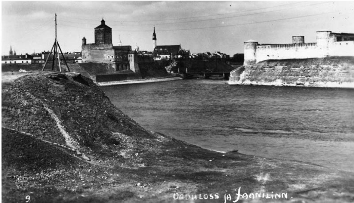
Ivangorodin linnoitus (oikealla) ja Narvan linna vuonna 1929. Linnoitusten restaurointi toteutui 1840–1860-luvulla ja saattoi tarjota Viipurin insinöörikomennuskunnalle esimerkin paikallisen insinöörikomennuskunnan toteuttamasta restaurointiprojektista.
