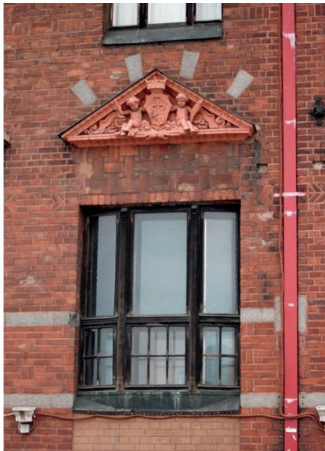
Suomen Pankin Viipurin konttorin julkisivussa on useita koristeellisia yksityiskohtia kuten kuvassa näkyvät ikkunoiden yläpuoliset päätykolmiot ja vaihteleva tiilimuurauksen limitys.
