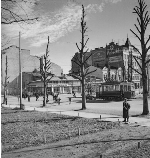
Jatkosodan jälleerakennuskautta: keväällä 1943 raitiovaunut palasivat Viipurin katukuvaan ja Torkkelinpuistoa oli saatu siistittyä. Valokuvaaja: sotilaskirjuri J. Taube. SA-kuva. 126462.
