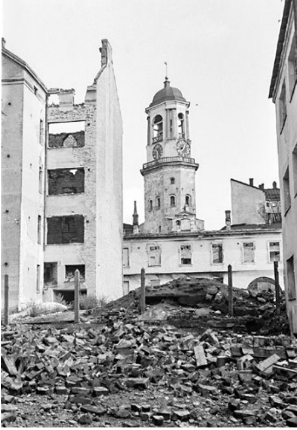
Kuva 4. Kellotorni. Valokuvaaja: Aukusti Tuhka. SA-kuva. 42268.
