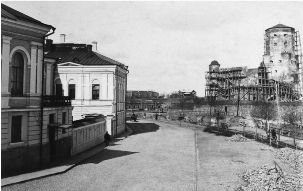
Viipurin linnaa korjataan 600-vuotisjuhlia varten 1890-luvun alussa. Vasemmalla vanha Hackmanin talo.
