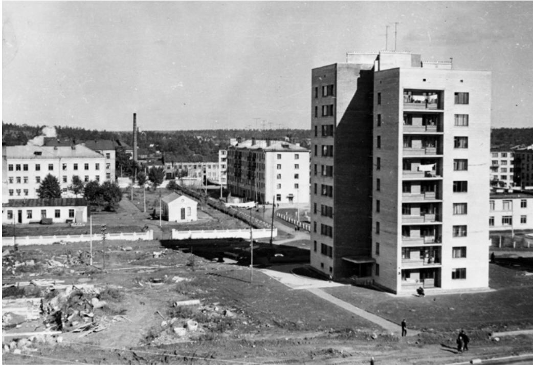
Yksi Viipuriin rakennettavan uuden asuinalue A:n kolmesta panoraamakuvasta kuvattuna vuonna 1967 rakenteilla olevasta talosta käsin
