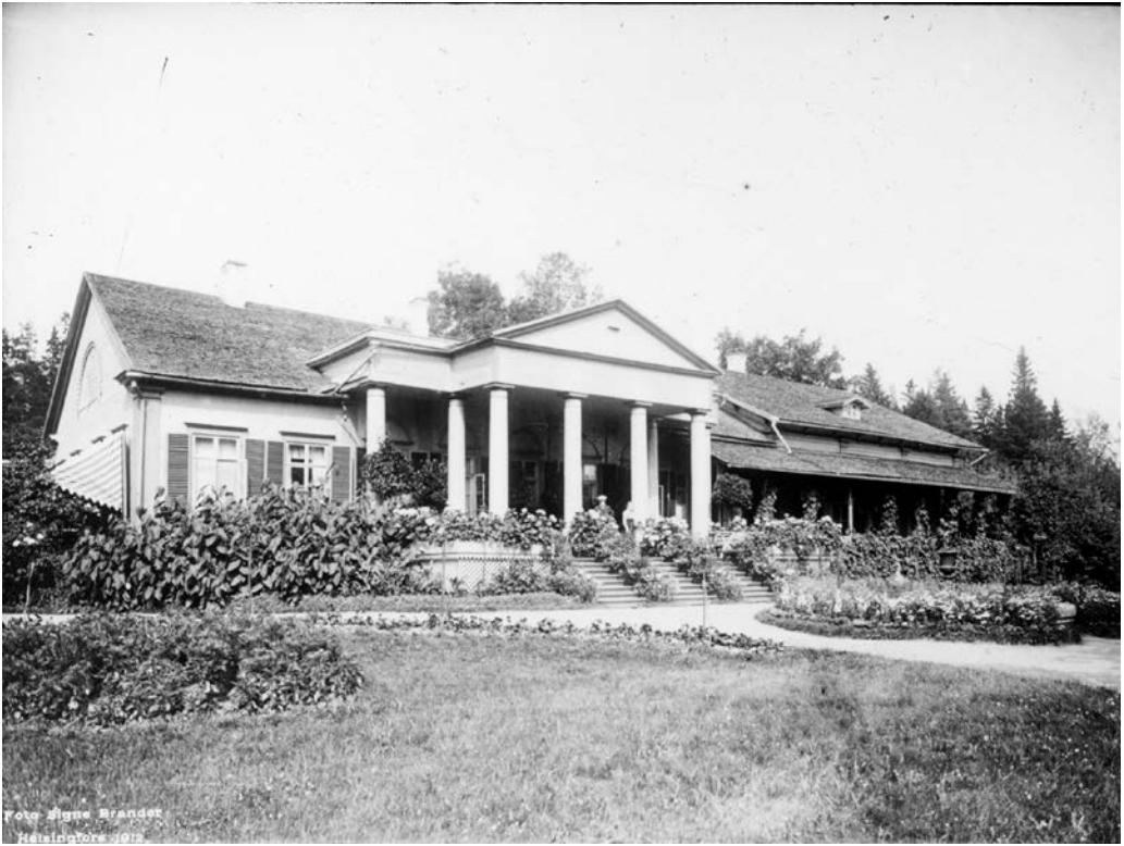
Viipurin lukio toimi Johann Friedrich Hackmanin Lauben tilalta siihen tarkoitukseen luovuttamassa rakennuksessa. Kuvassa tilan päärakennus Herttualan kartano.
