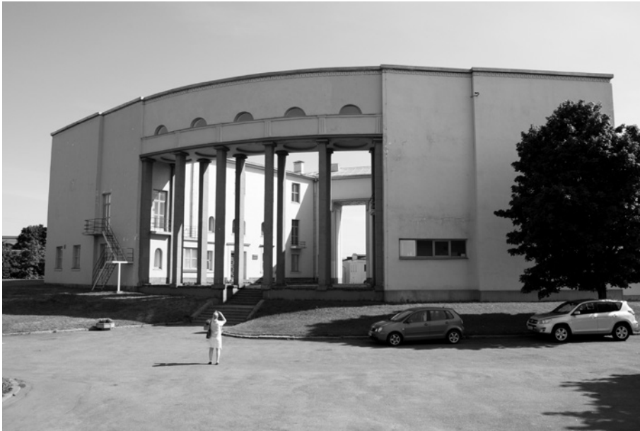
Viipurin kunnostettu taidemuseo meren puolelta katsottuna vuonna 2014.
