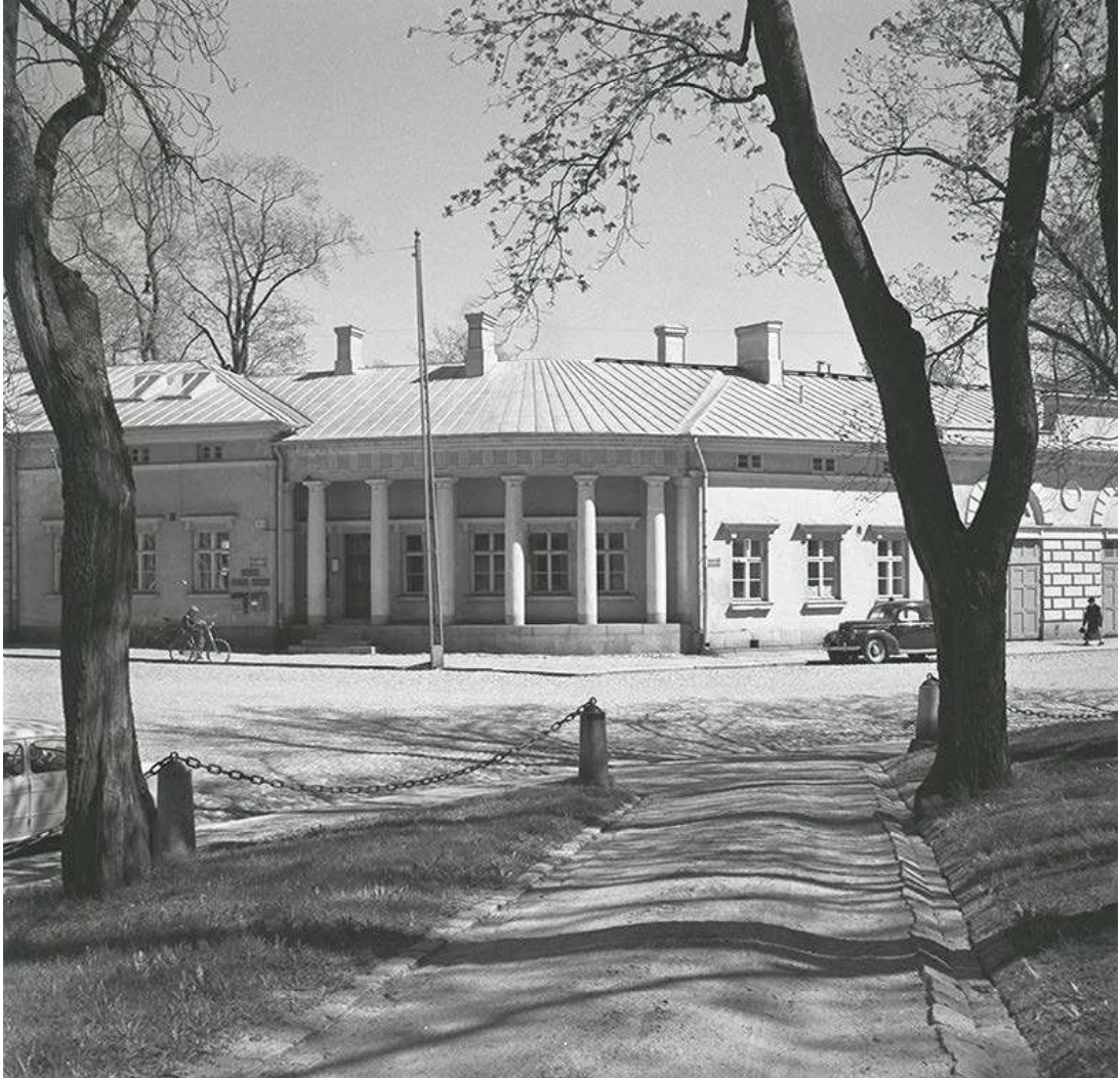
KUVA 4 Maaherran makasiini lisäosineen Gardbergin kuvaamana 1957. Lisäosaan kuuluvat pylväin varustettu kulma sekä rakennuksen vasemmanpuoleinen osa. Kuva: Carl Jacob Gardberg/Turun museokeskuksen kuva-arkisto.
