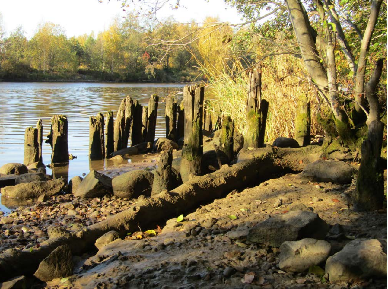
KUVA 5 Ihmisen ja luonnon aiemmat vuorovaikutusprosessit näkyvät kaupunkiluonnossa sekä elävän luonnon rakenteina että artefaktien jäänteinä. Luotsinmäenjuovan rannat ovat olleet aikoinaan kauttaaltaan paalutettuja uiton helpottamiseksi. Paalutus esti tukkien juutumista kiinni rantahiikkaan ja sumien syntymistä. Kuva: Ilona Hankonen 2020.
